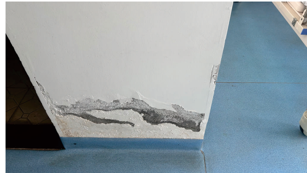
1-5楼原脱落、起壳、以及脏墙面修补、刷漆
