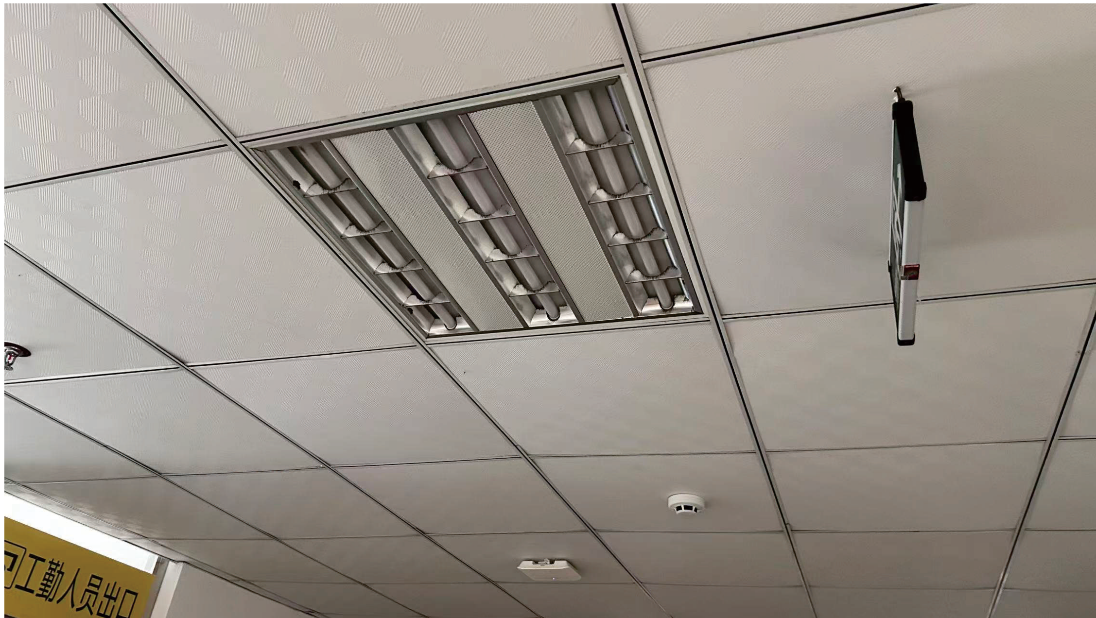
1-5楼原老式灯更换为600*600LED平板灯 新装吊顶灯为600*600平板灯
